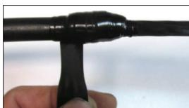
**2.11** Удалить внутреннюю оболочку ОК по принятой технологии на длине 2 м, отступив от бандажа на 70 мм.
