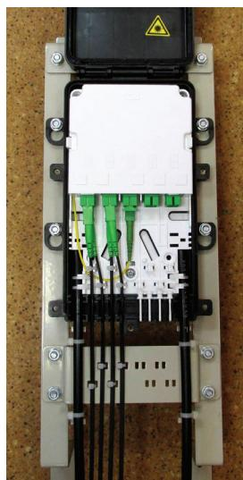
**3.1.5** В случае ввода в муфту ОКСН (в соответствии с 2) после размещения и закрепления вставки в корпусе муфты зафиксировать кабель за внешнюю оболочку металлическим хомутом на нижнем Т-образном выступе кронштейна, а за внутреннюю оболочку стяжкой полиэтиленовой на верхнем (ориентированном в сторону муфты) Т-образном выступе кронштейна
