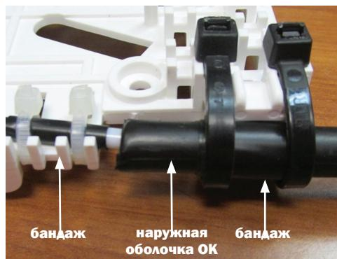
**1.8** Из арамидных нитей сформировать 2 пучка и, пропустив один из них через отверстие в корпусе вставки (рисунок «а»), через которое стяжкой закреплен кабель, завязать пучки между собой. На каждом из пучков возле узла сделать бандаж из 2-3 витков ленты виниловой и обрезать излишек длины арамидных нитей каждого пучка в 2-3 мм от бандажа (рисунок «б»).
