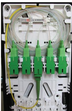
**1.11.6** Установить крышку вставки. Разместить вставку в корпусе муфты-кросса и закрепить вставку 3-мя крепёжными винтами.
